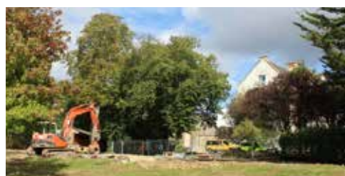
Début octobre 2020 : la pelleuse vient de démolir deux bâtiments...
