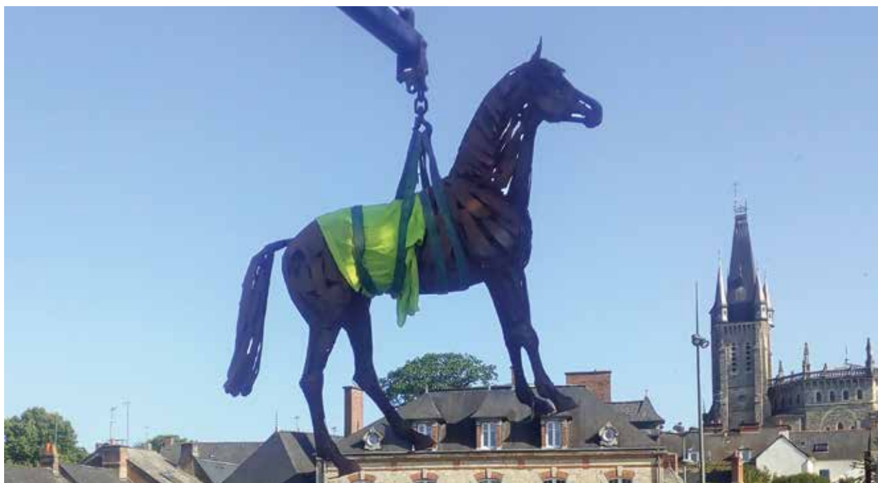
15 mai | Un cheval dans le ciel de Châteaubourg... lors de l'installation du Jardin des Arts !
