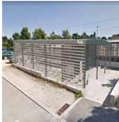
Un nouveau parking sécurisé sera installé à cet emplacement.
