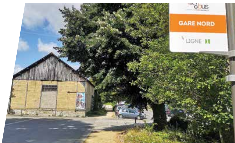
Le hangar de la gare, ici pendant l'été 2020, sera démoli en cette fin d'année.
