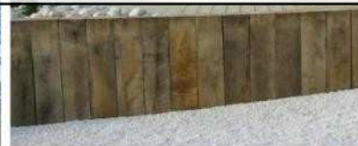
exemple de soutènement réalisé en bastaings bois
