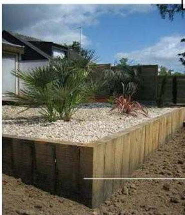
exemple de soutènement réalisé en bastaings bois
