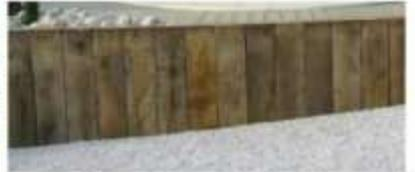
*exemple de soutènement réalisé en bastingis bois*
