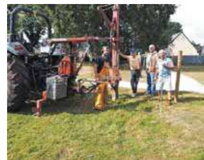
Les bénévoles de l'association Du Coq à l'Âne pendant la construction de l'enclos.
