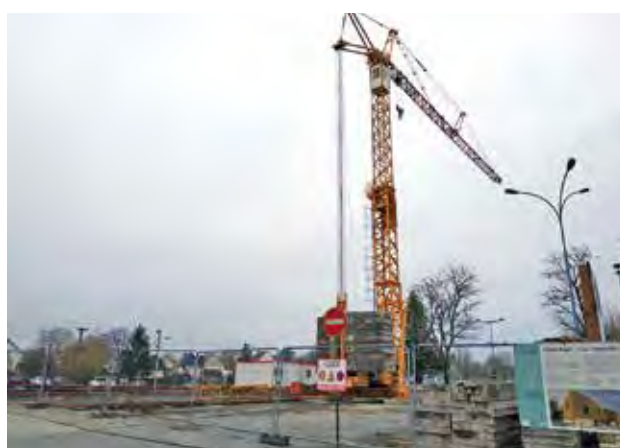
14 janv. Chantier médiathèque : démarrage du gros œuvre.
