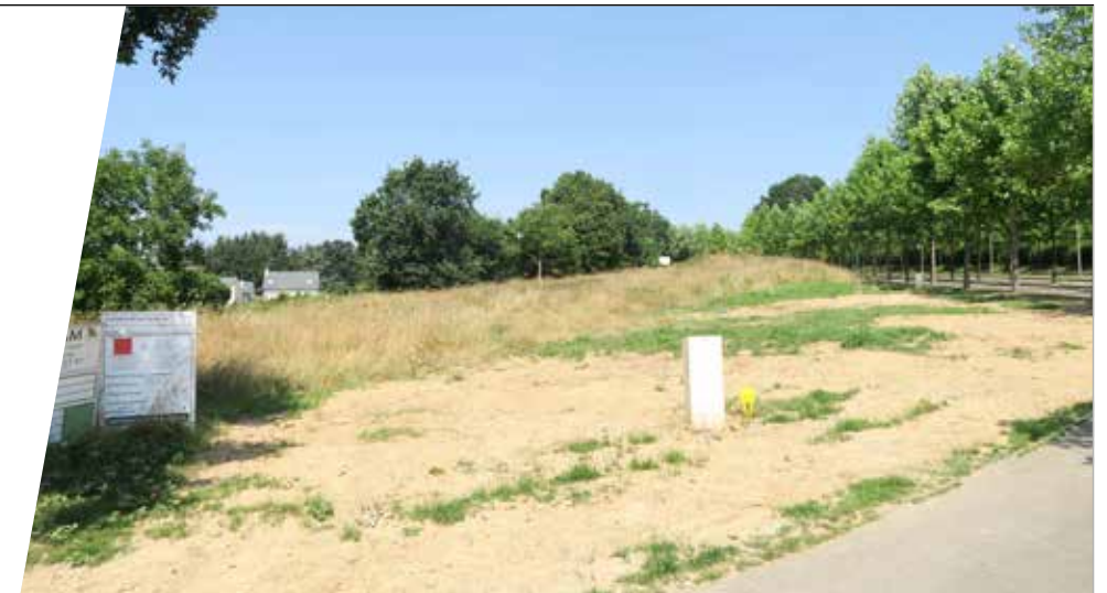
La viabilisation a commencé sur le chantier de la future Maison de Santé, ZAC des Jardins de la Bretonnière
