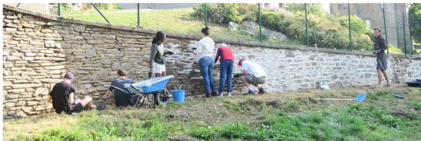
11 juillet | Les jeunes volontaires du chantier international œuvrent à la restauration du mur du parc Pasteur.
