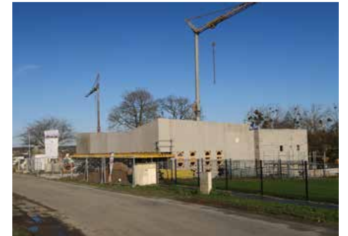
18 déc. La nouvelle Gendarmerie sort de terre dans la zone de la Bourlière.
