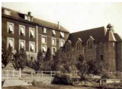
La façade sud, côté parc Pasteur
